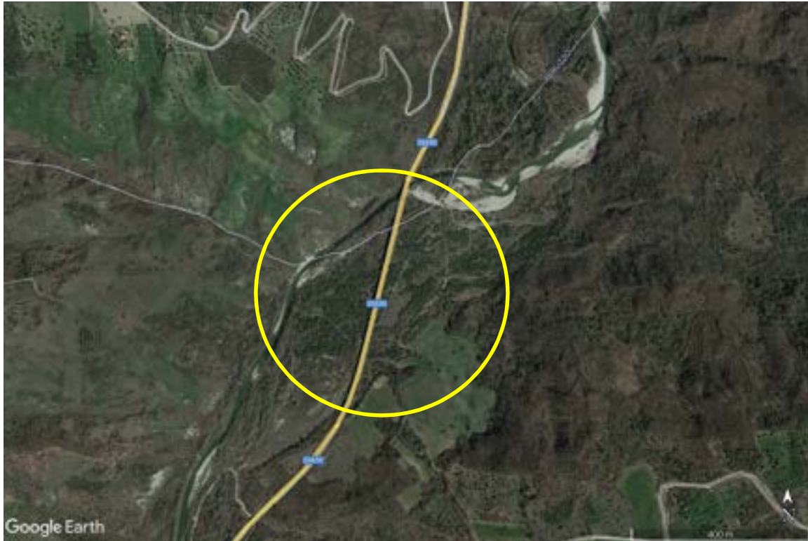
Tratto di strada statale con pericolosità idraulica elevata e rischio medio (come meglio evidenziato sulla tavola del rischio idraulico).
